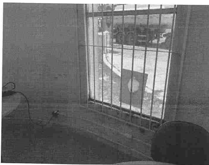
Figura 3 - Vidros da Secretaria quebrados
