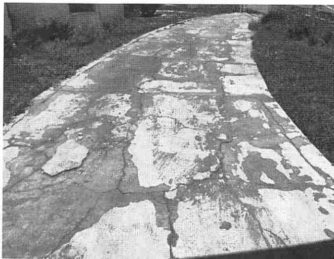
Figura 2 - Baía de entrada de autos. demolição e refazimento.
